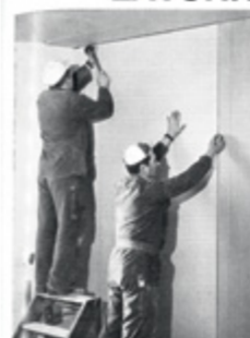
Install. de cloison de Plât à Support
