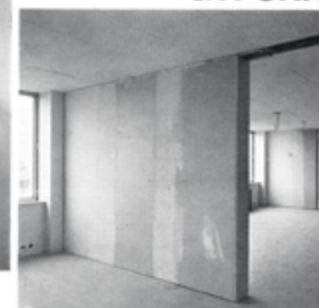
Bruxelles 1000 - Avenue de Woluwe, Bruxelles
